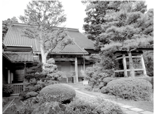
調査を行った石川県七尾市・覚永寺（2017年8月）
