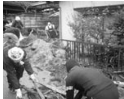
復旧作業（宮津市）
