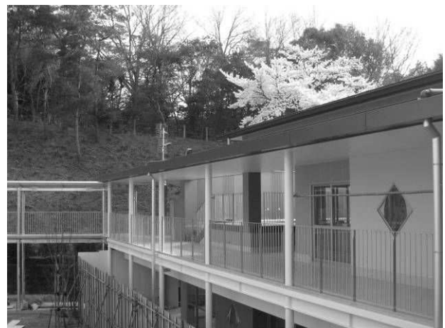
(2011年12月に竣工した新園舎棟)
