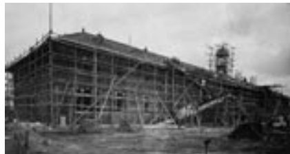
建設中の尋源館(旧本館)
