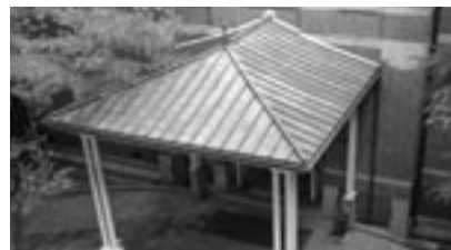
改修された尋源館車寄
